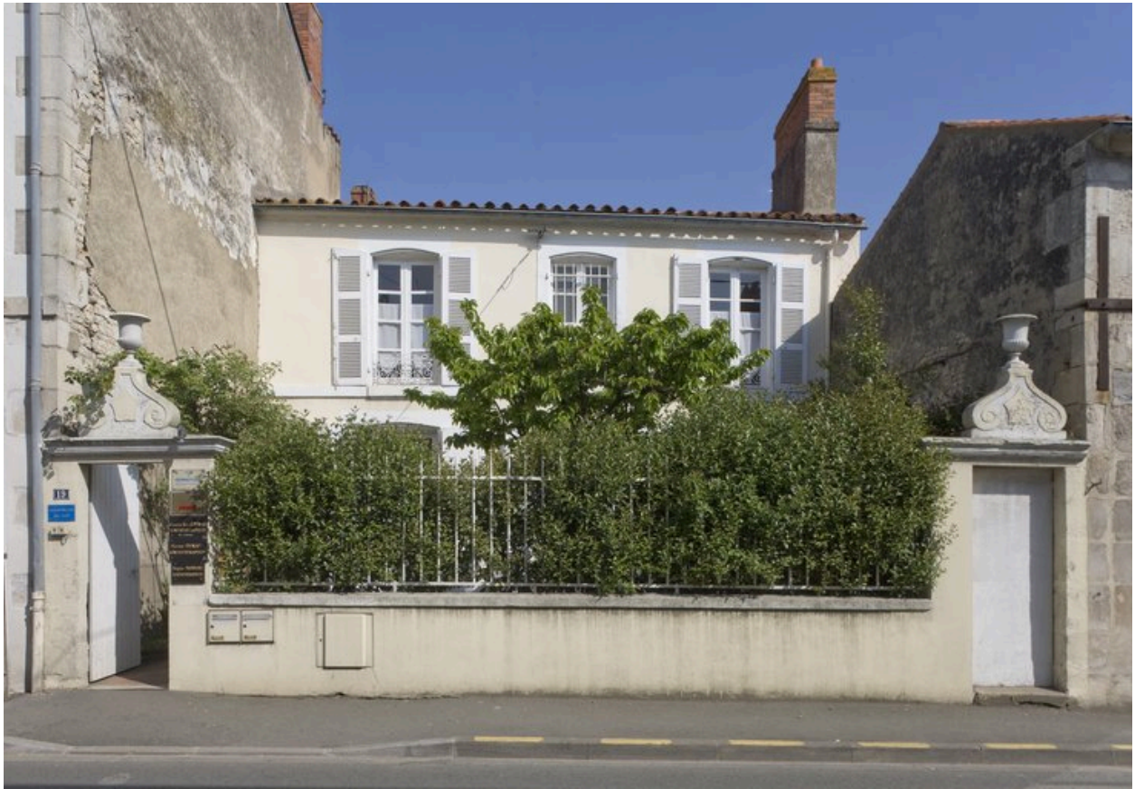
Façade sud, sur cour antérieure.
