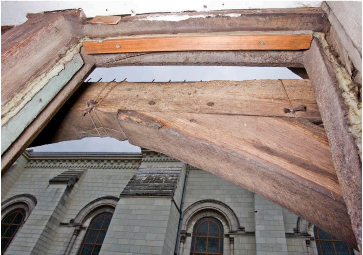
Elévation antérieure, ferme de tête du pignon : détail sur l'assemblage du faux-entrait et des aisseliers courbes, à travers la fenêtre de l'étage de comble.
