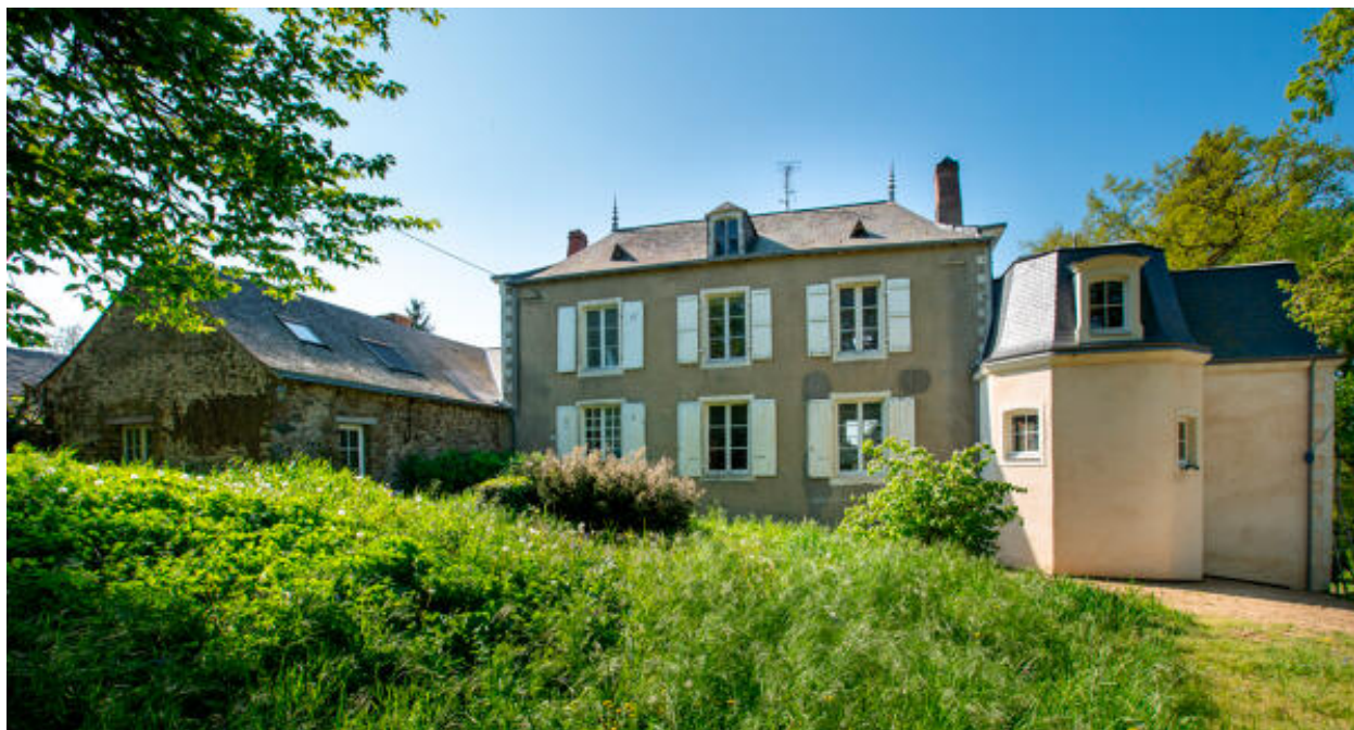
La demeure, élévation postérieure.
