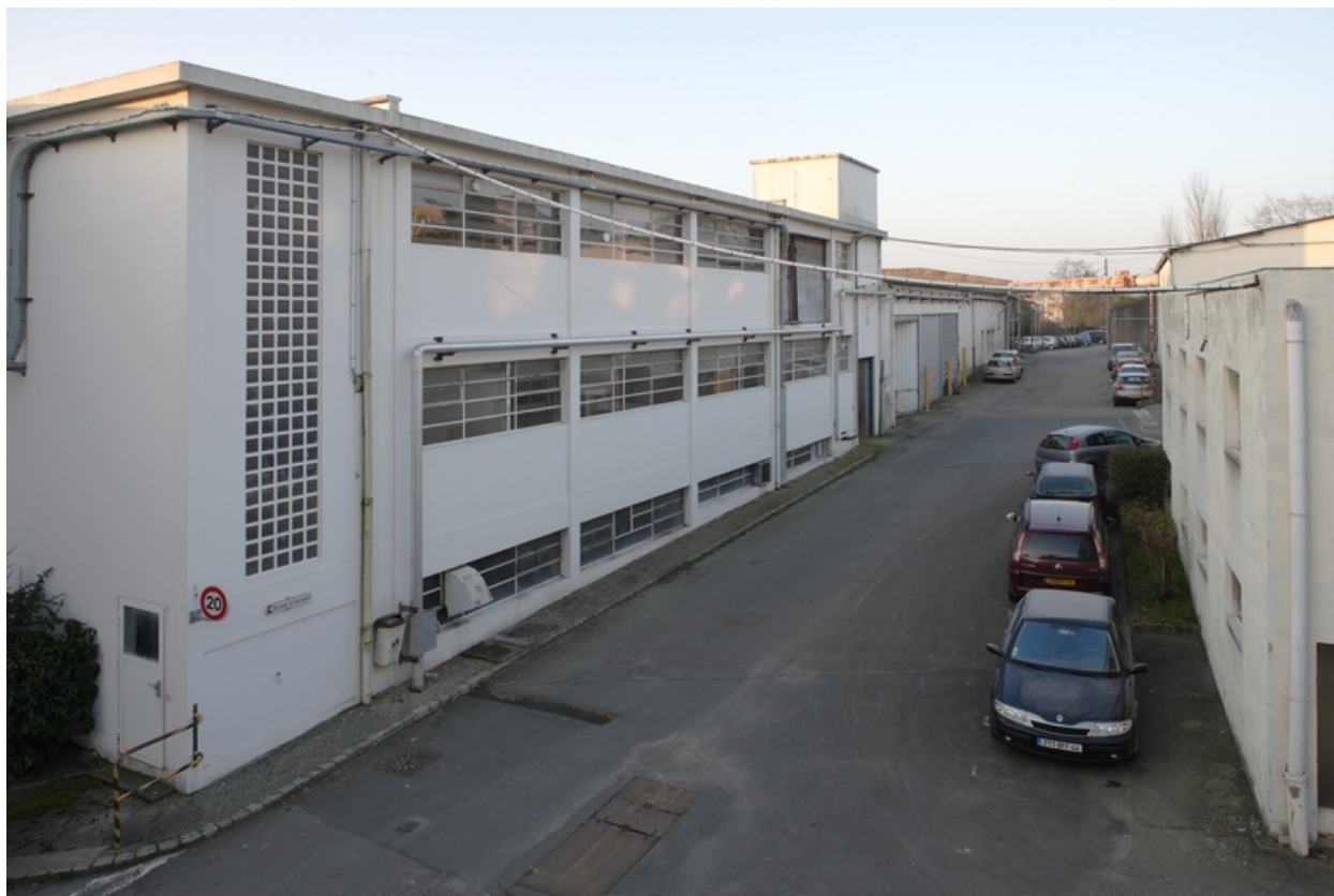
Atelier de fabrication 1, côté cour.
