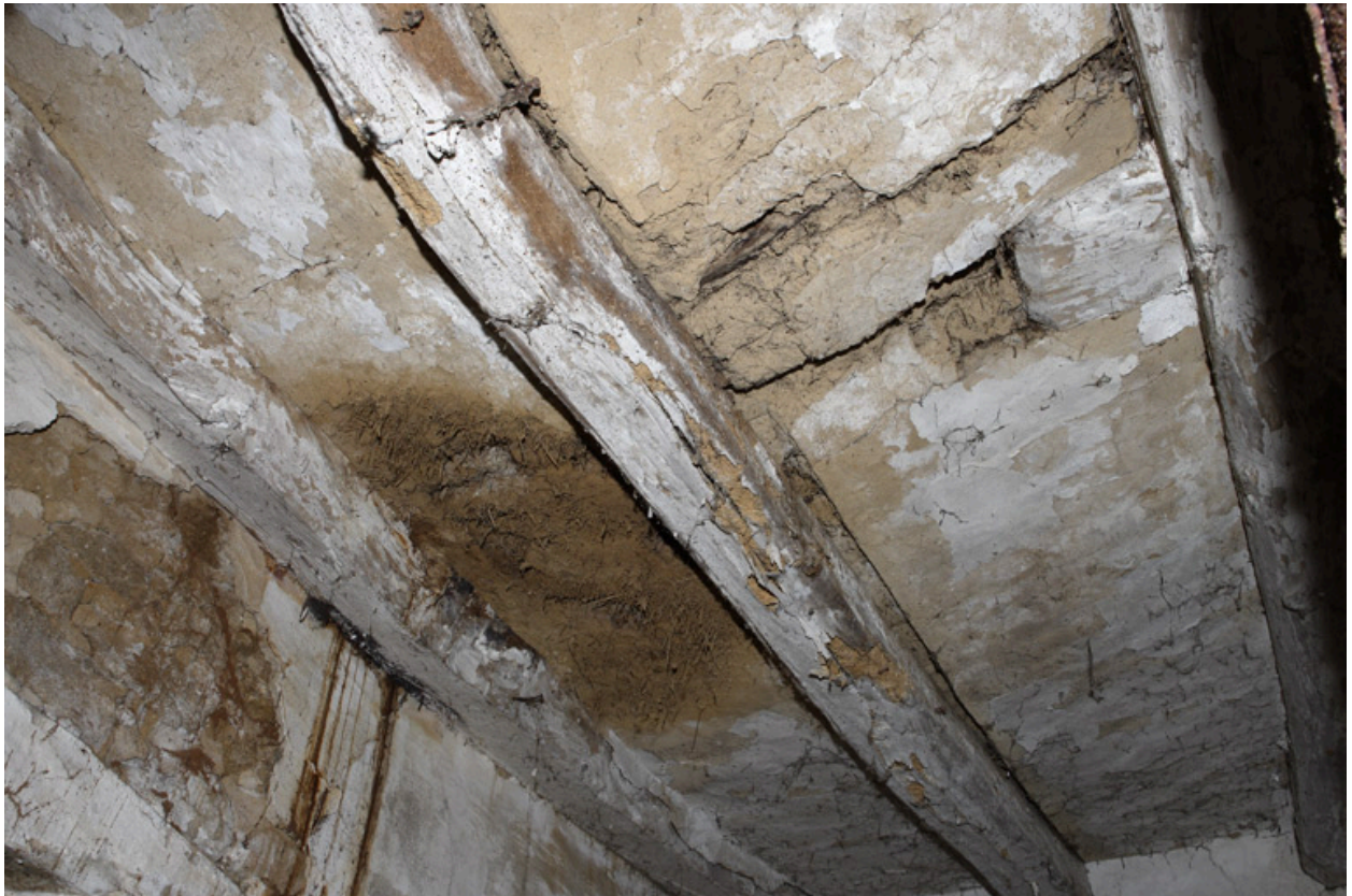
Aile sud. Détail du plafond en torchis.
