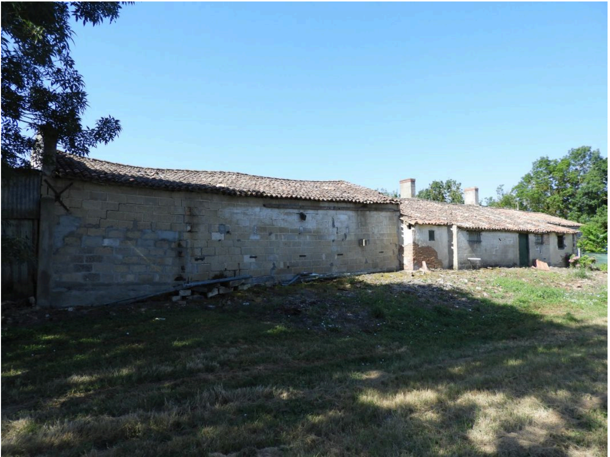
L'ancienne ferme vue depuis le nord-est.
