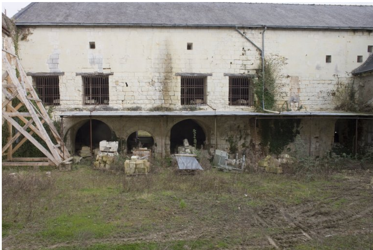
Prieuré de la Madeleine, aile est du cloître, ancien dortoir, façade ouest. Parties hautes et barreaudages d'époque pénitentiaire (XIXe siècle).
