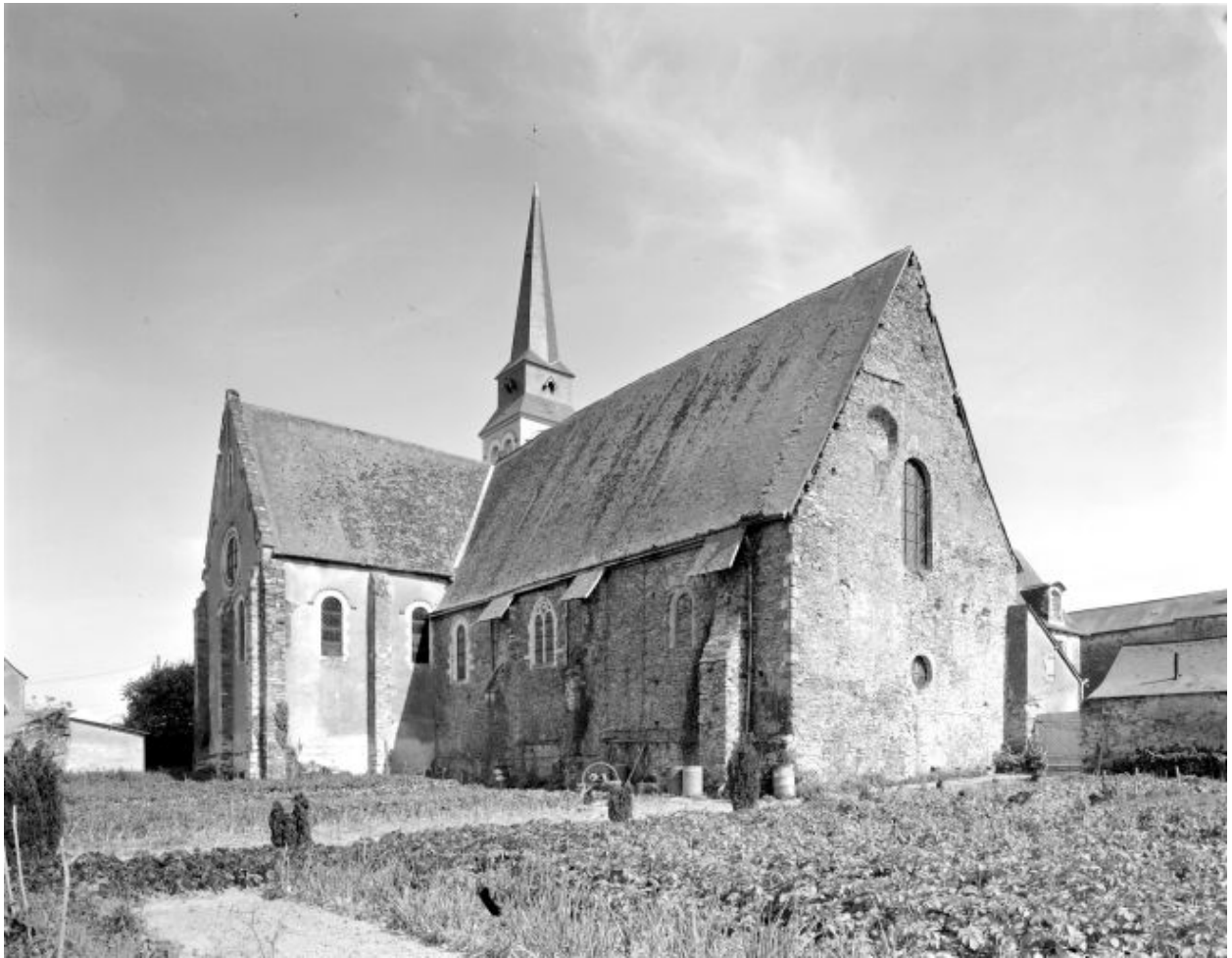
Vue d'ensemble de l'église depuis le nord-ouest avant la découverte des thermes.
