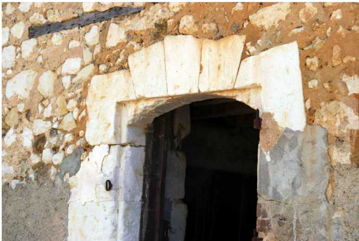
La grange-étable : détail du linteau remanié.
