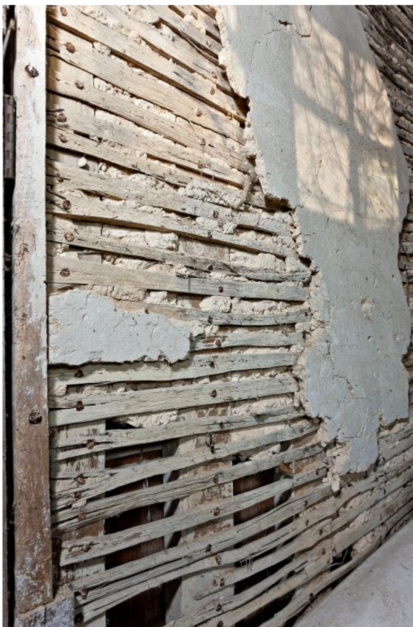
Dépendance 1, RdCh : détail d'une cloison à pan de bois en torchis sur lattis.
