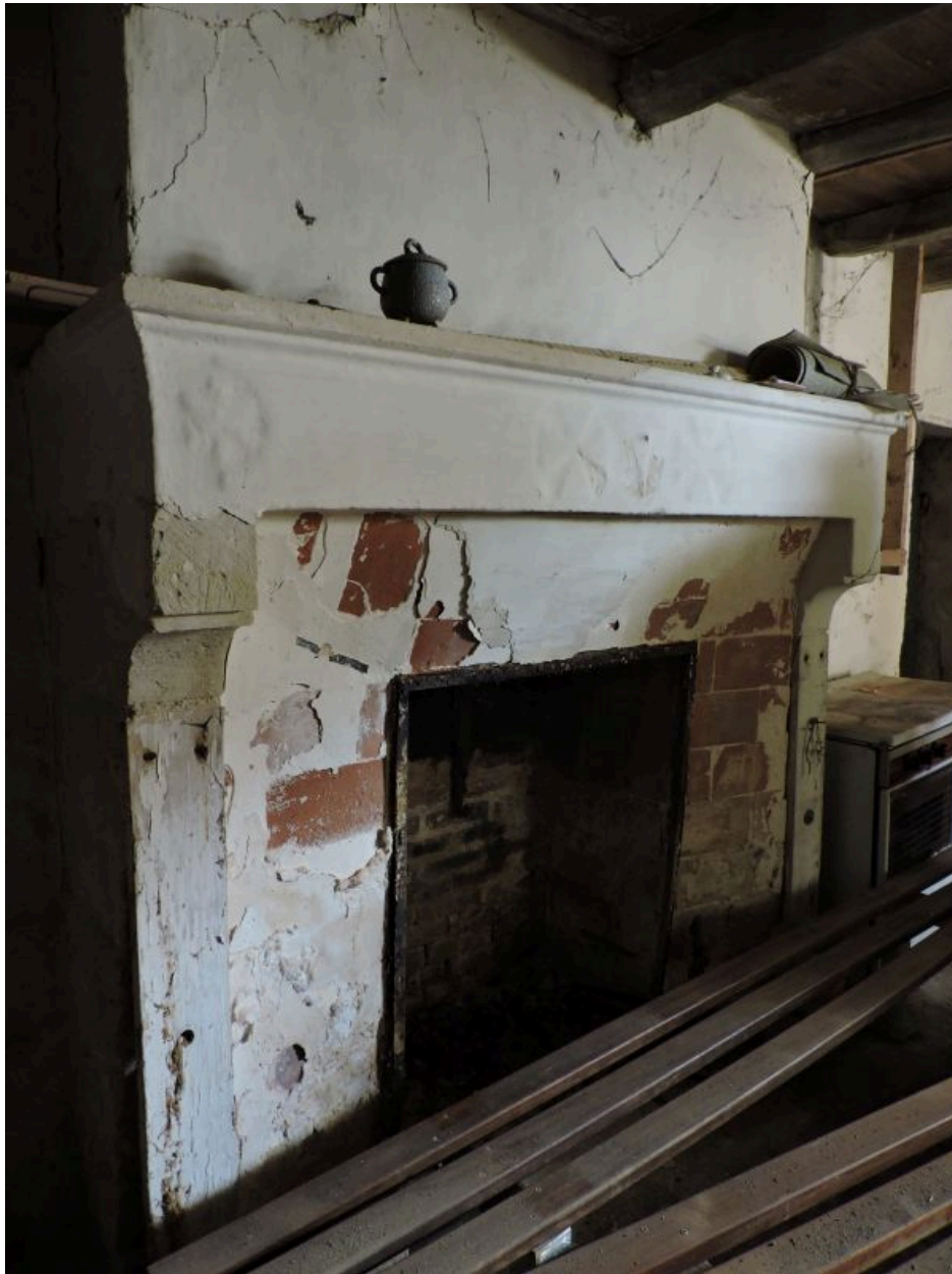
La cheminée à l'intérieur du logement sud.
