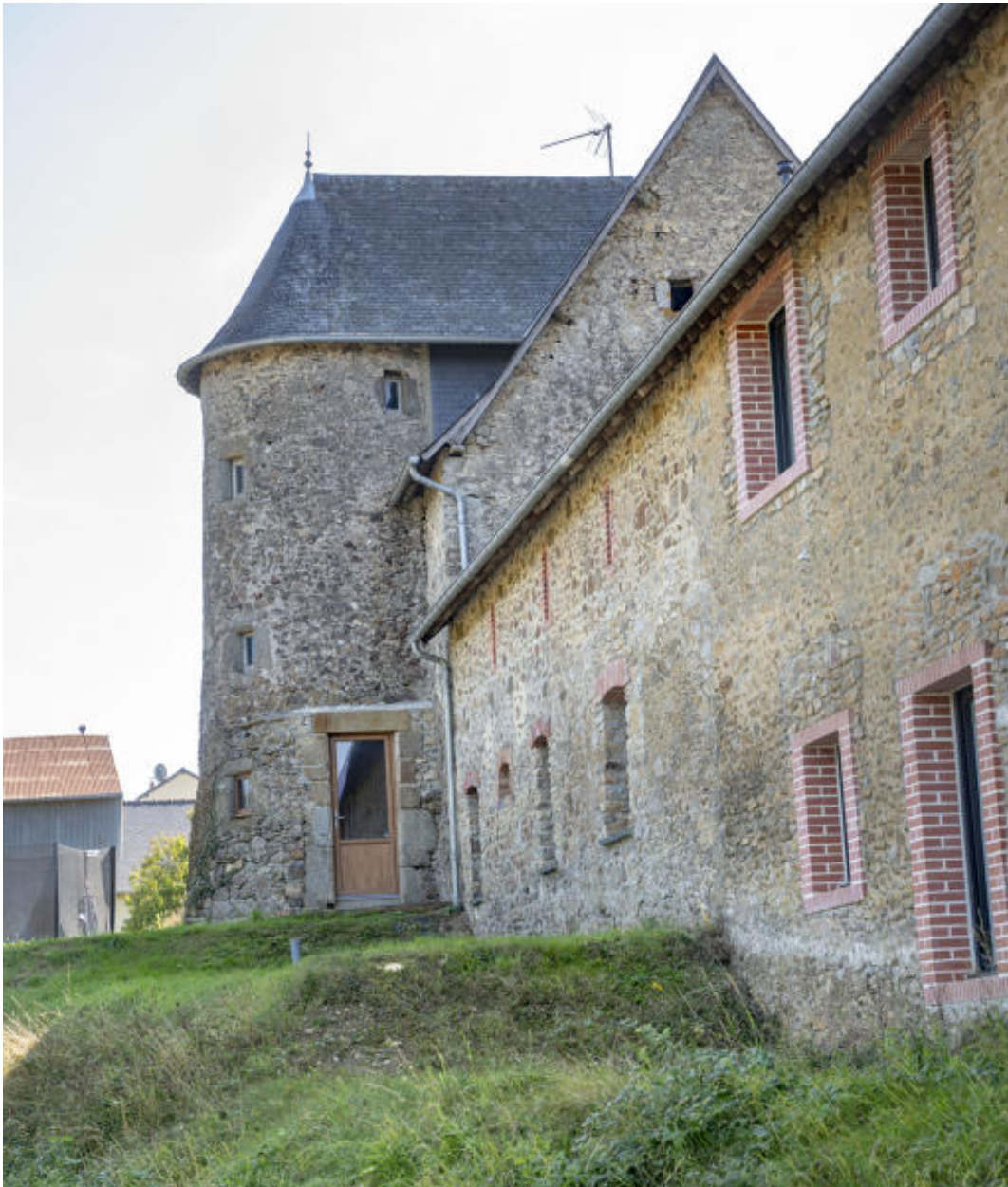
La tour d'escalier du logis.
