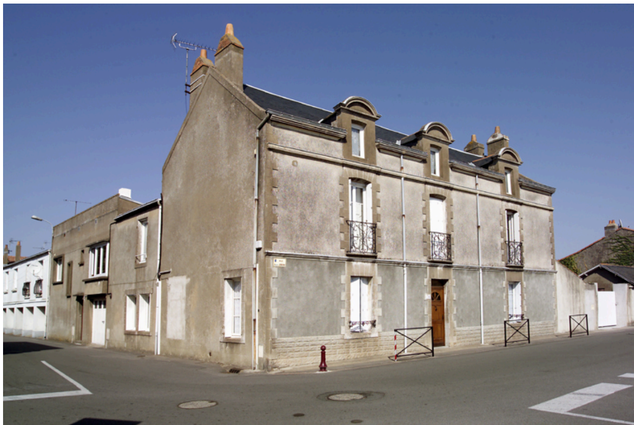
Vue de la maison n° 74 rue Pierre-Jubau depuis la rue.
