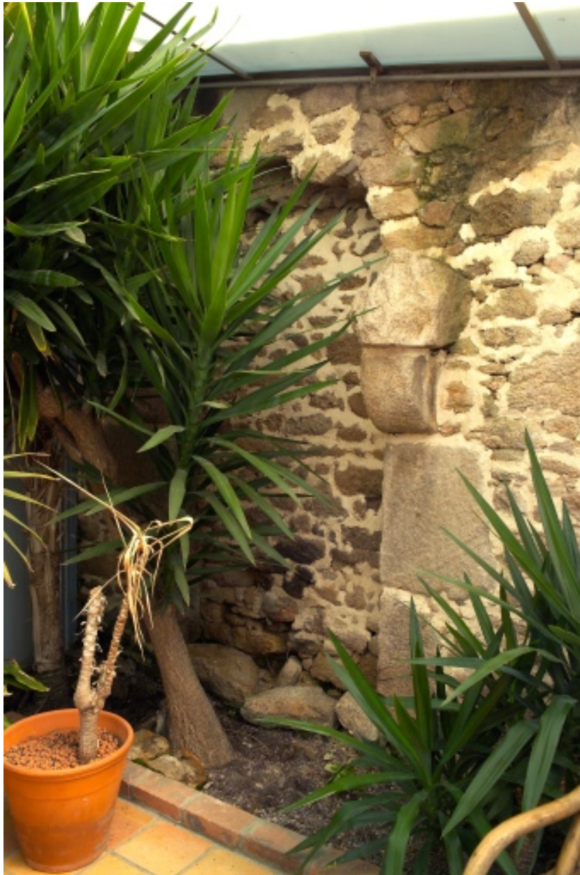
Cheminée de l'extension contre la partie orientale.
