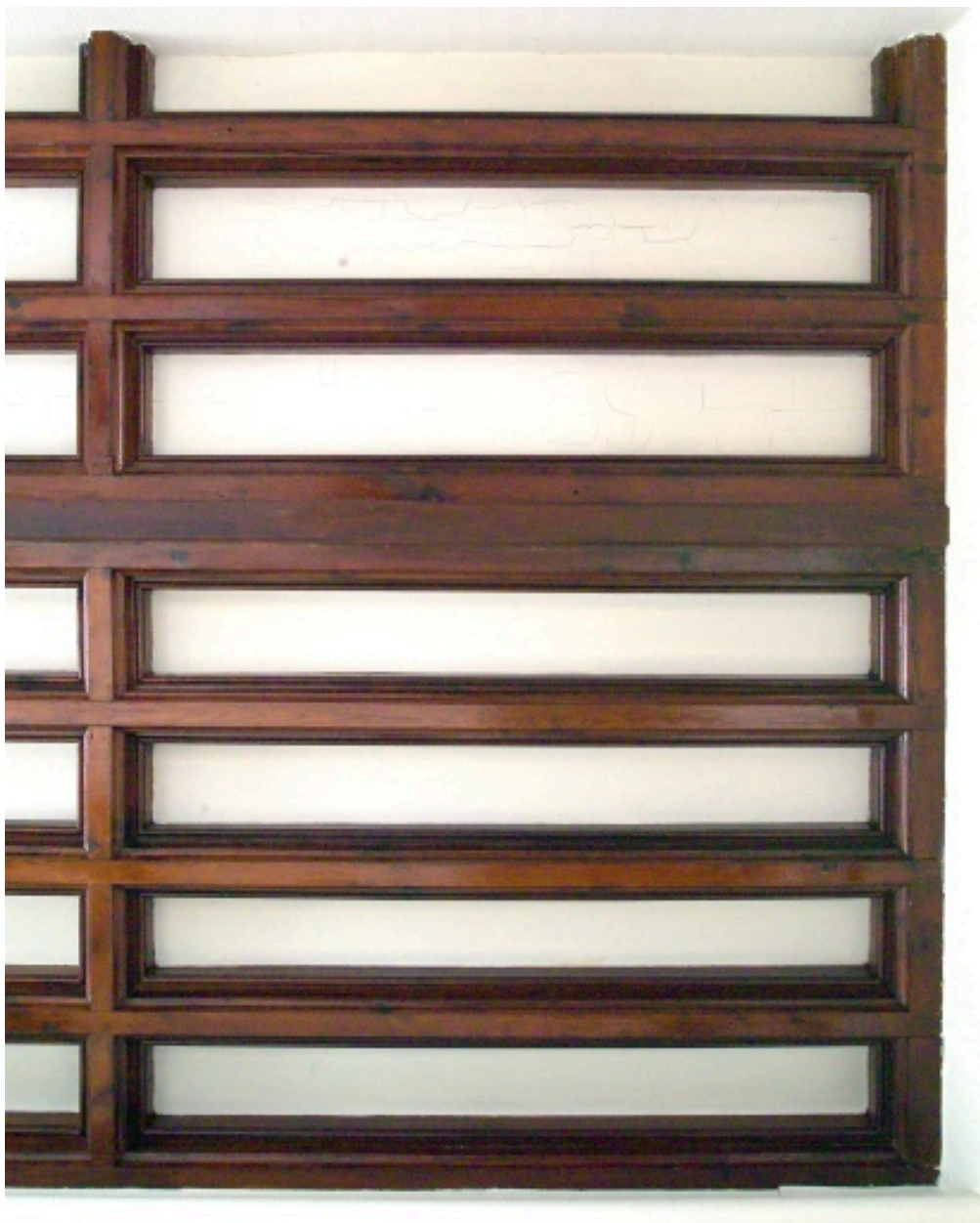
Vue du plafond dans le vestibule au rez-de-chaussée.
