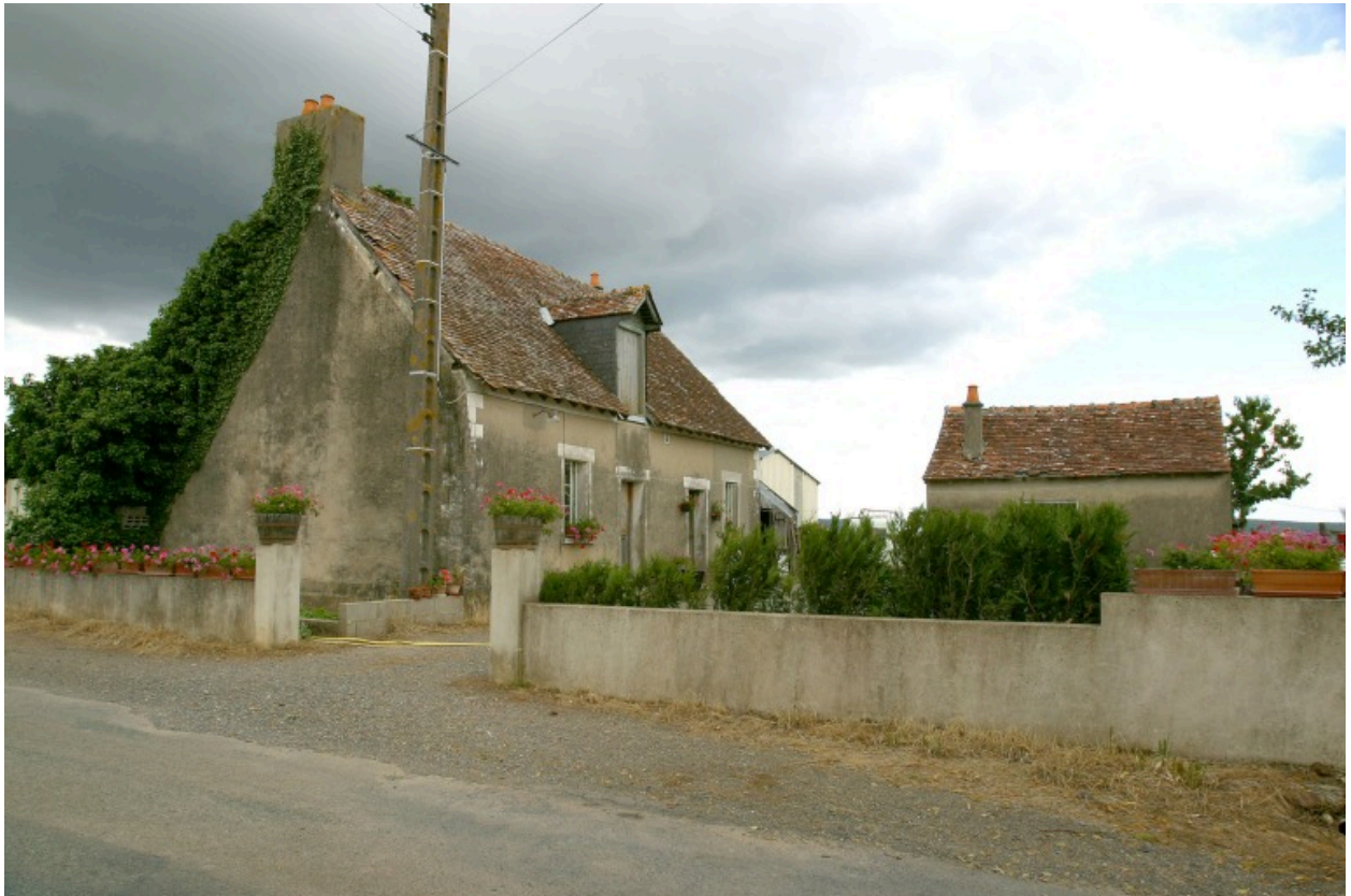
La quatrième maison vue depuis la voie communale au sud-ouest.
