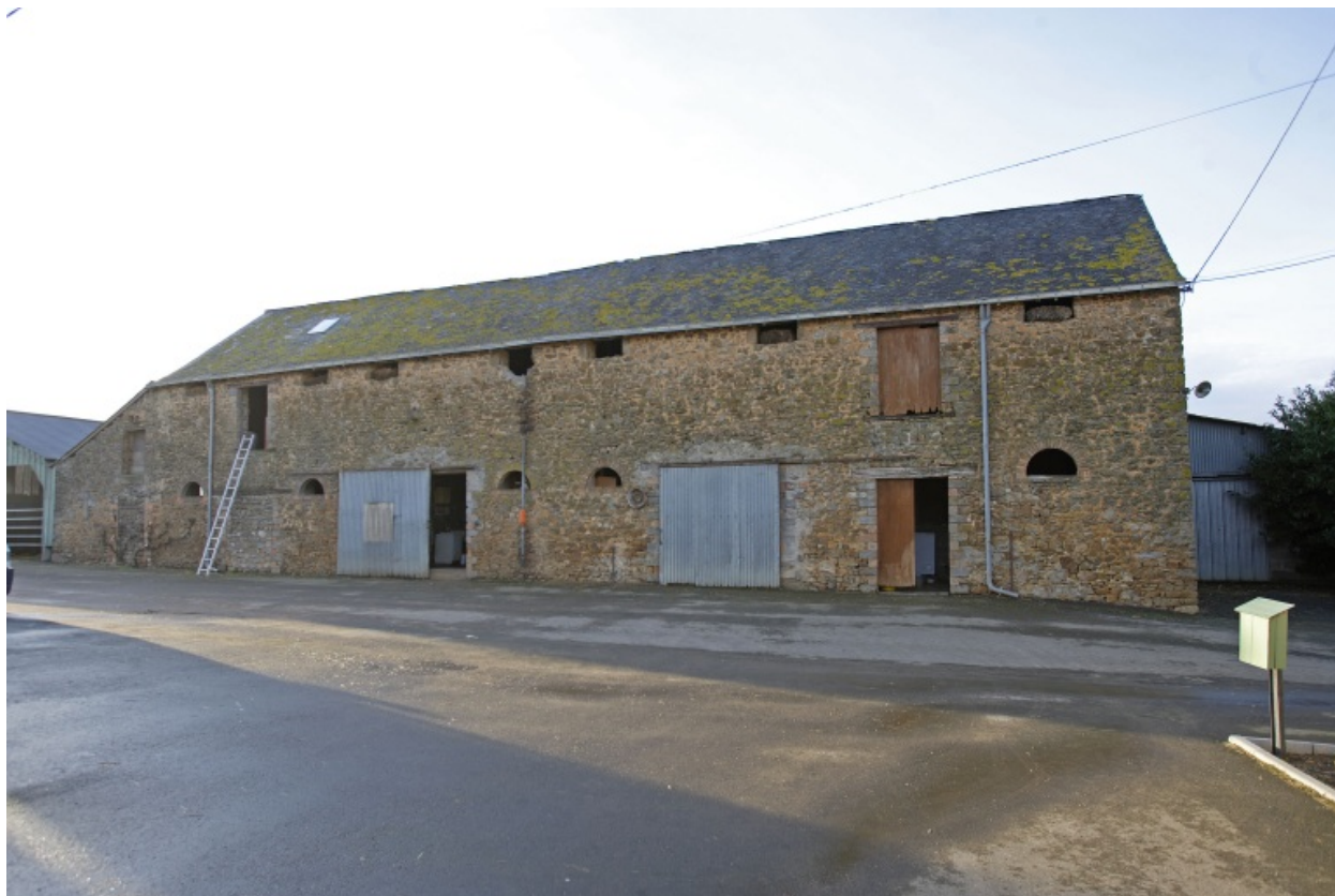
Ferme ouest : l'étable-grange vue depuis le sud-est.
