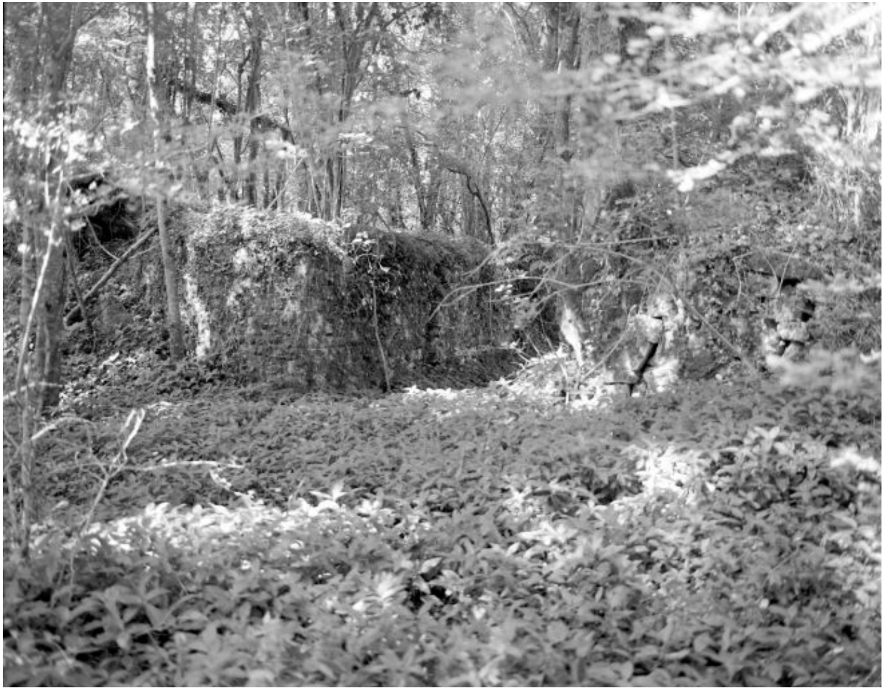
La chaussée et l'entrée du canal de décharge vus depuis l'ancien étang au nord-est.
