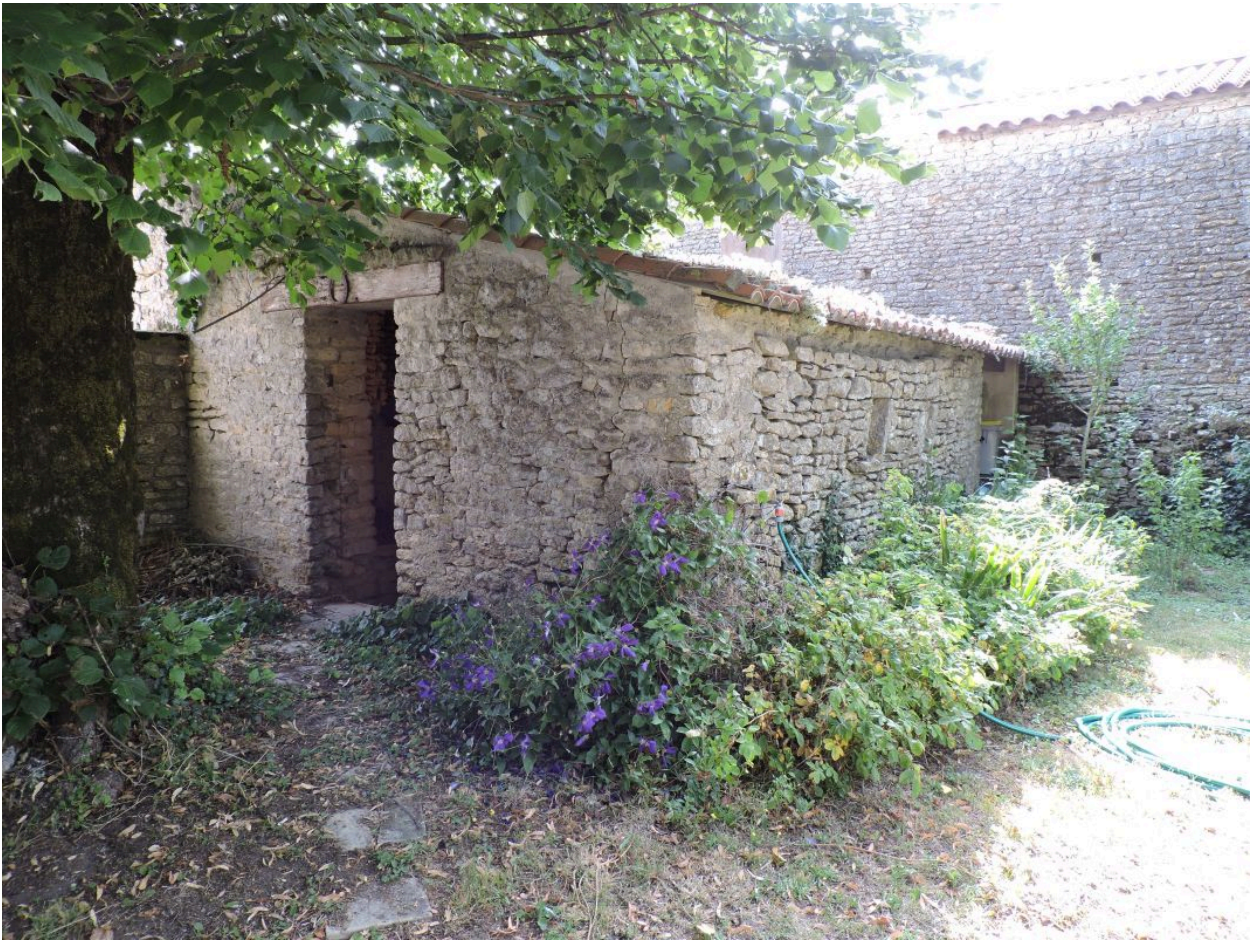
Le fournil-buanderie à l'angle est de la cour, vu depuis l'ouest.
