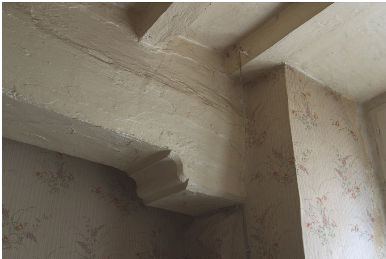
Rez-de-chaussée : détail de la poutre.
