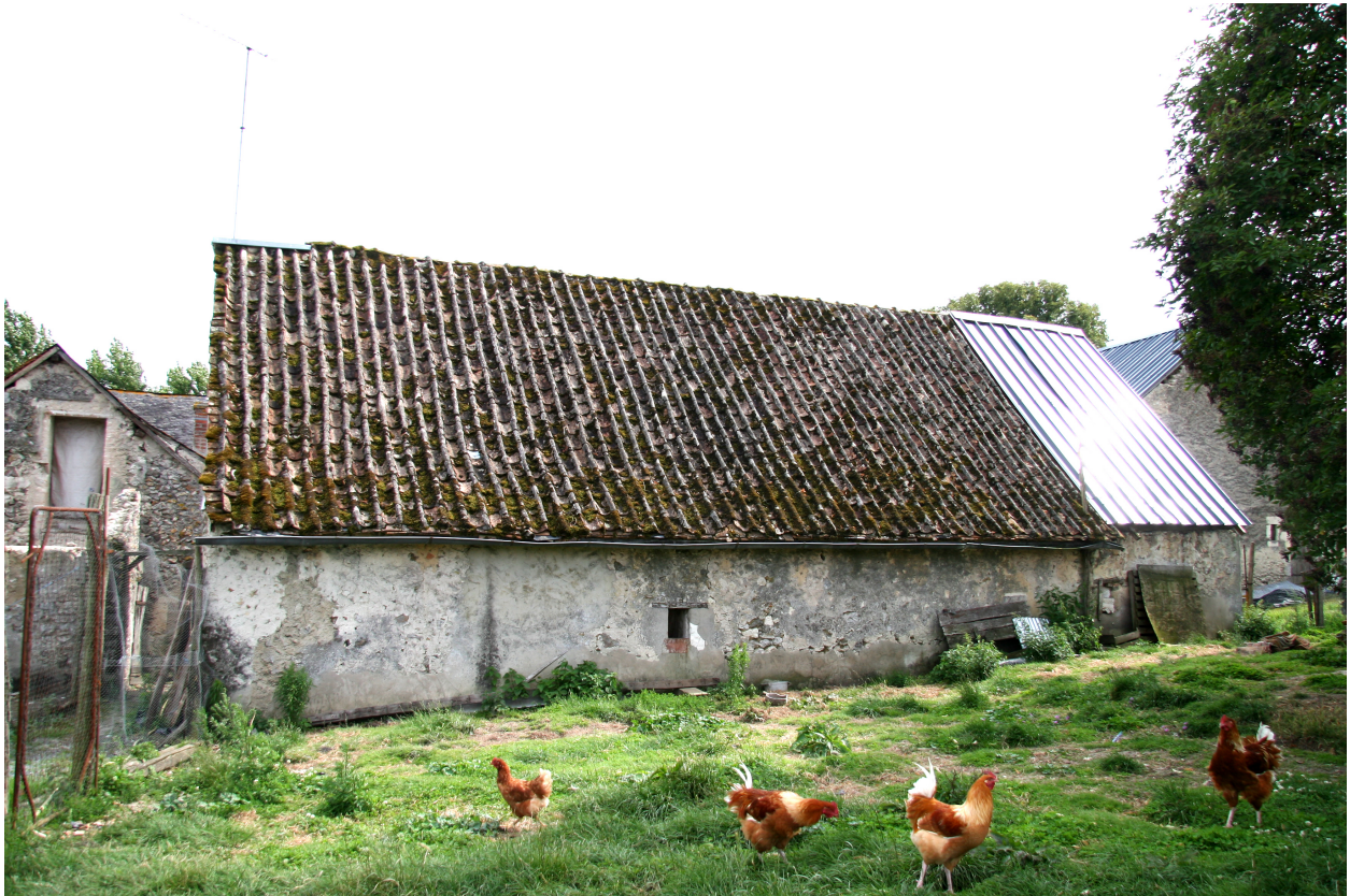
L'étable, façade postérieure : couverture de tuiles courbes.
