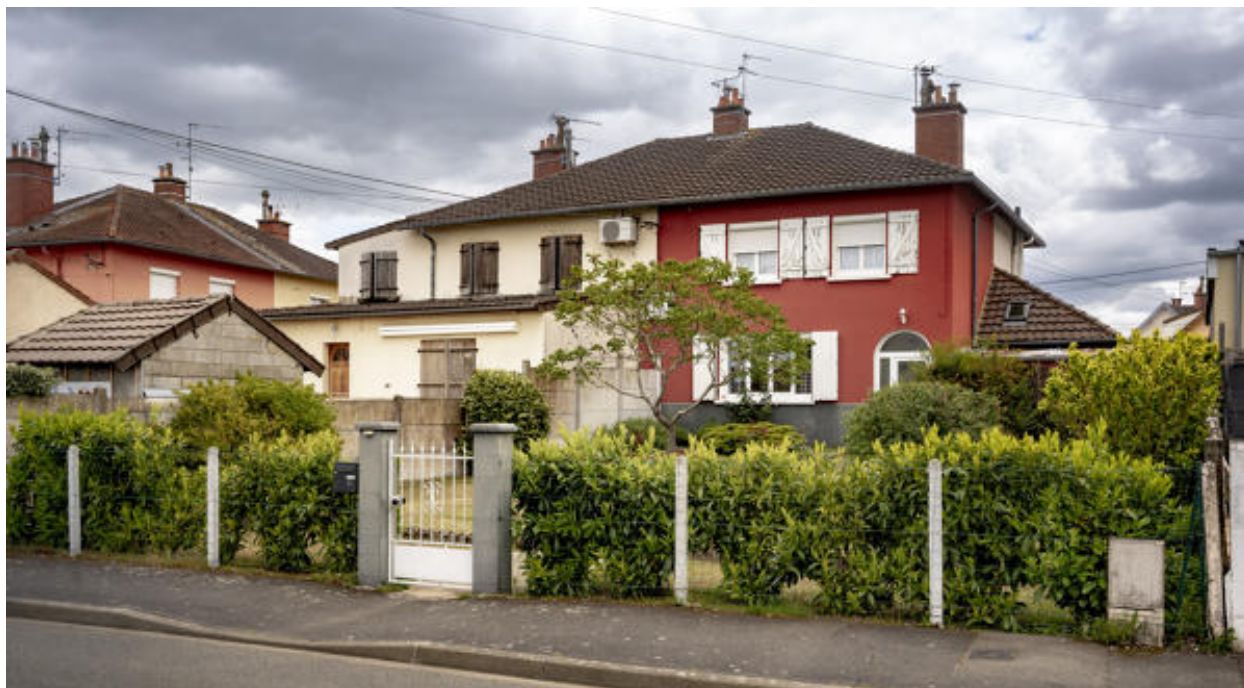
Vue de deux pavillons mitoyens de type C2.
