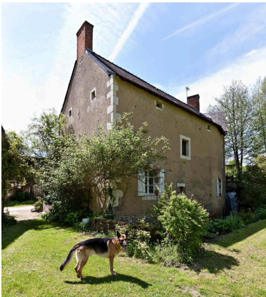
Maison vue depuis le nord-est. Chute d'eau au fond.
