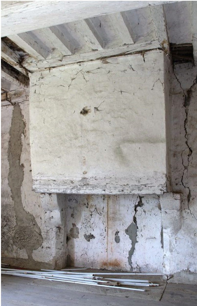
La cheminée de la pièce haute.
