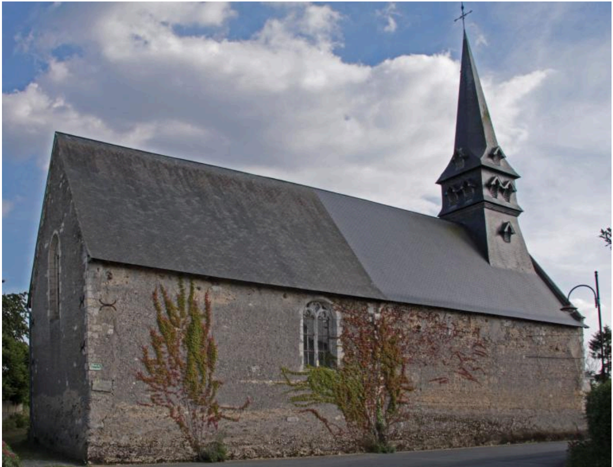
Façade nord de la nef.
