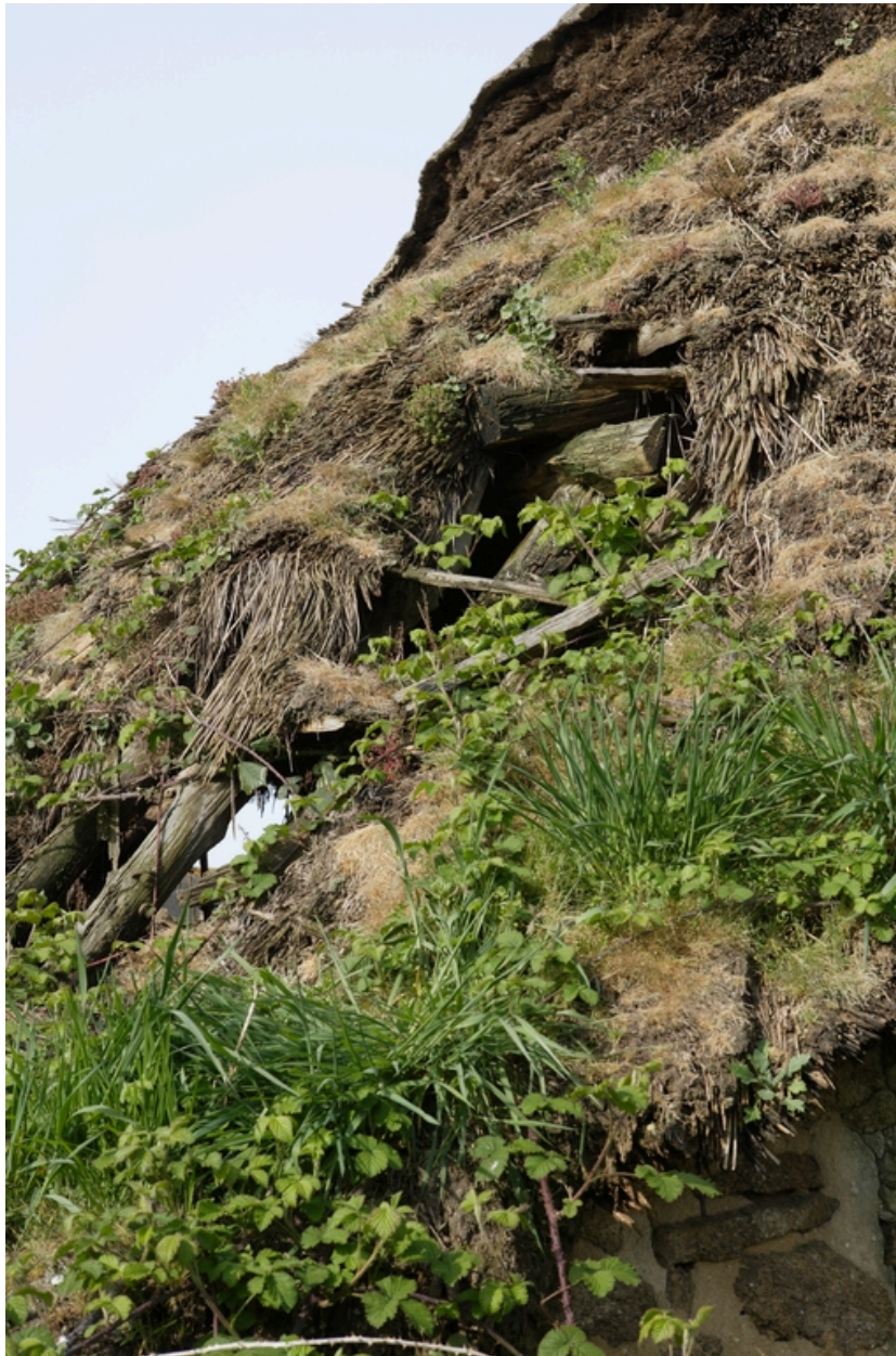
Détail de la couverture en roseau de l'ancien logis.
