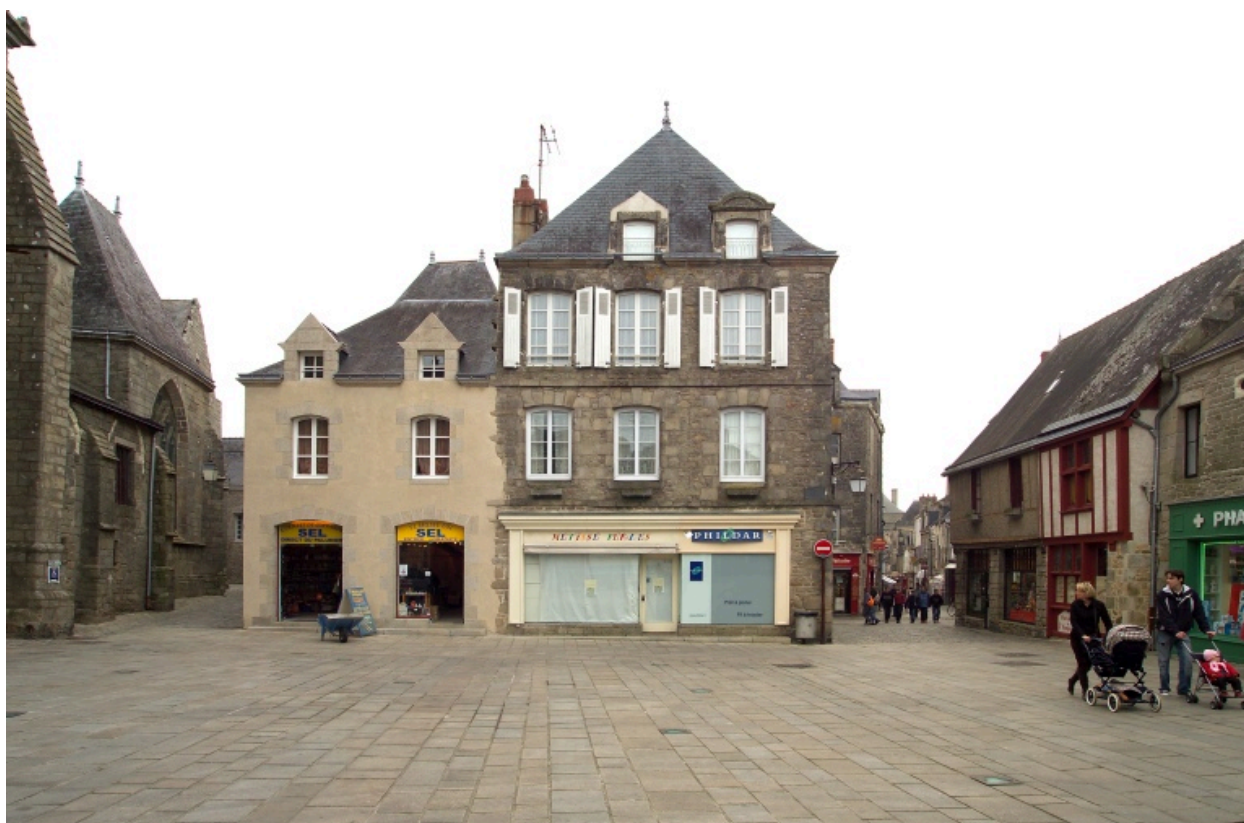
Vue de la place Saint-Aubin vers l'Est.
