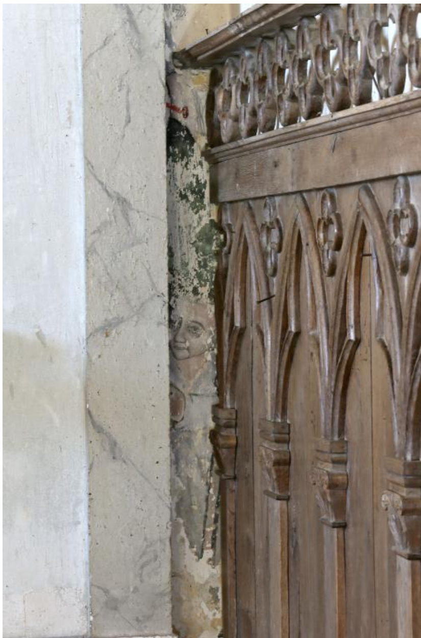
Chœur, mur oriental, côté sud, partie inférieure : détail d'un moine, les mains jointes.
