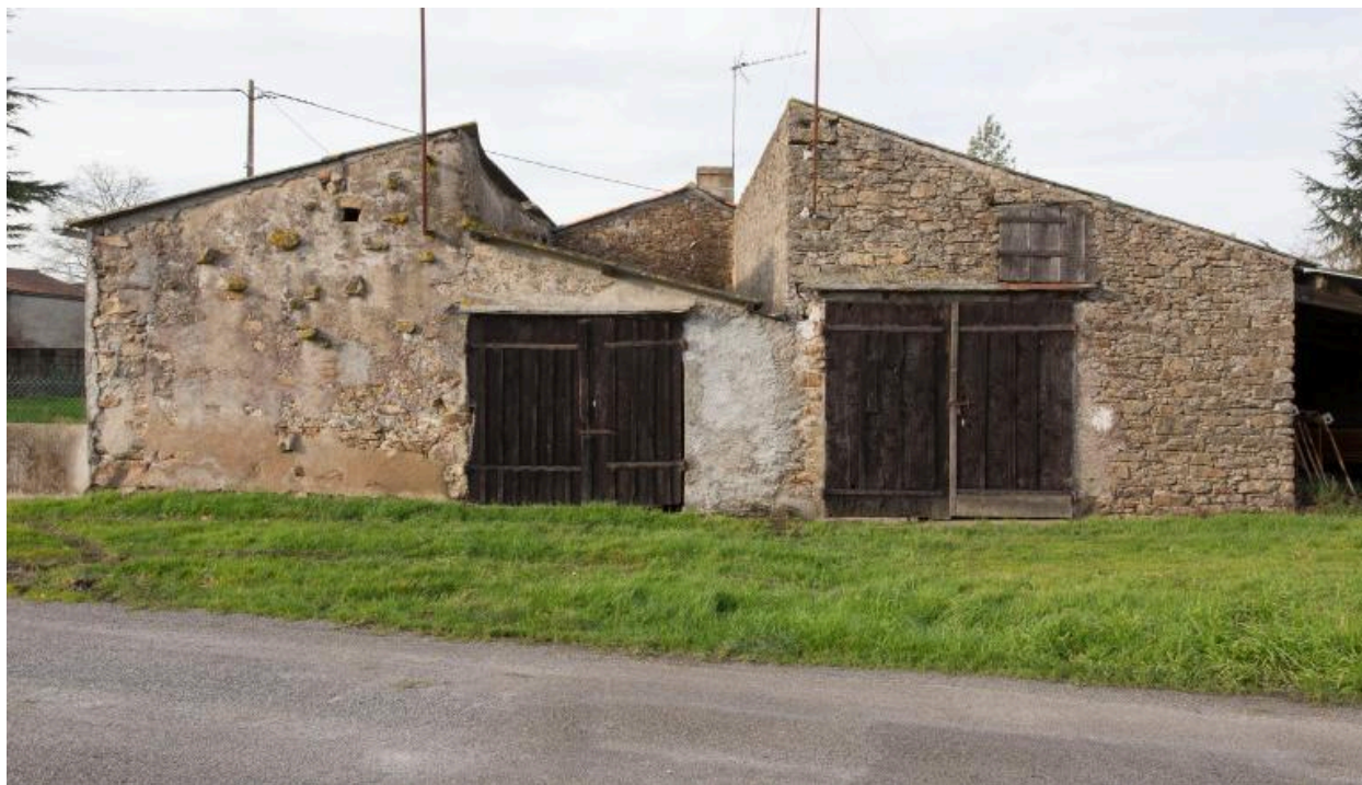
Ensemble de dépendances en appentis. La Bauche, Remouillé. Cadastre 2018, YH 01-109 et 110.
