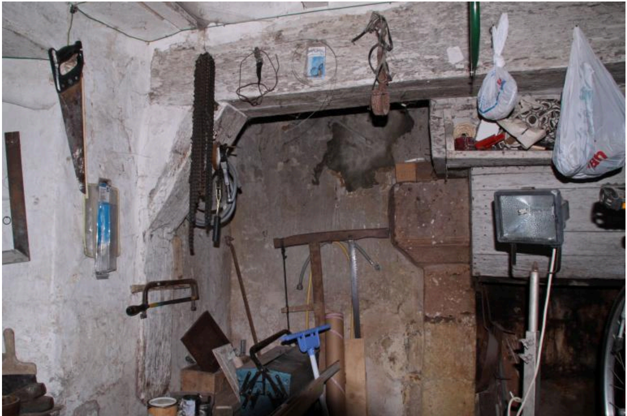
Maison 1 : ancien poteau de bois et cheminée (détail).
