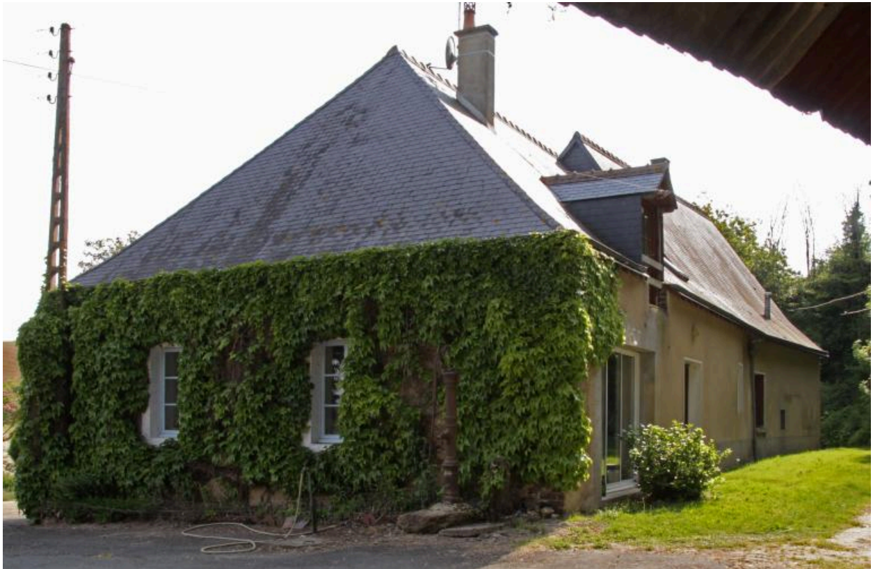
Vue de volume de la maison incluant la façade nord.
