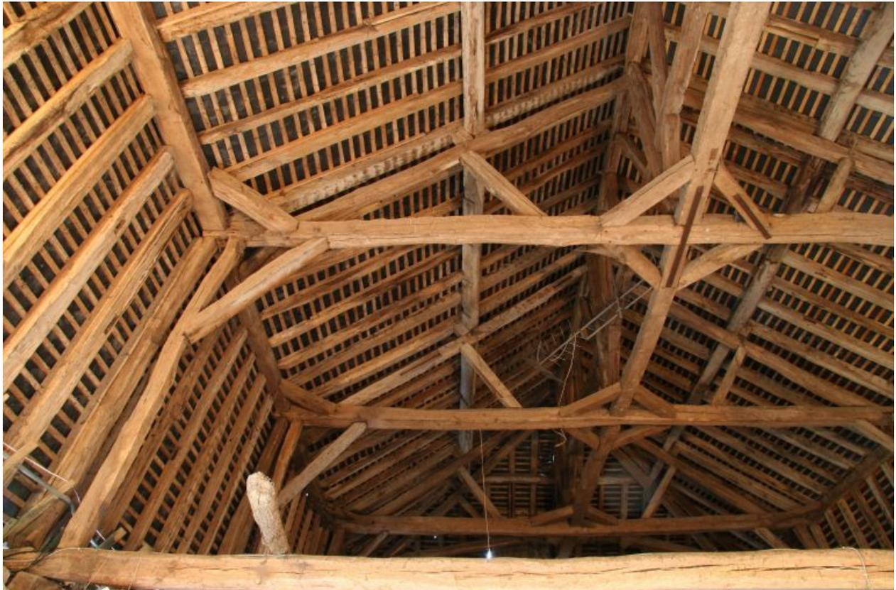
La grange : ferme de comble à surcroît et toit brisé.
