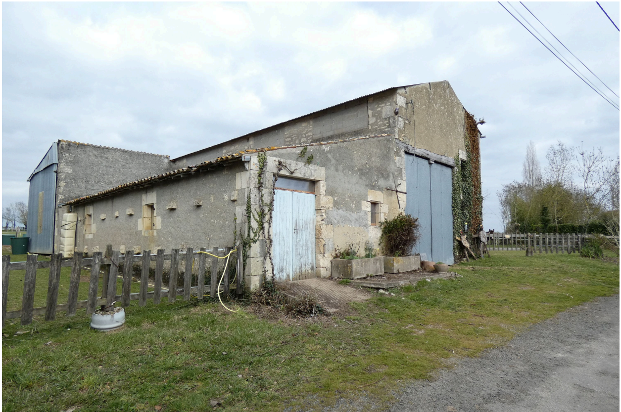
La grange-étable à façade en pignon vue depuis le sud-ouest.
