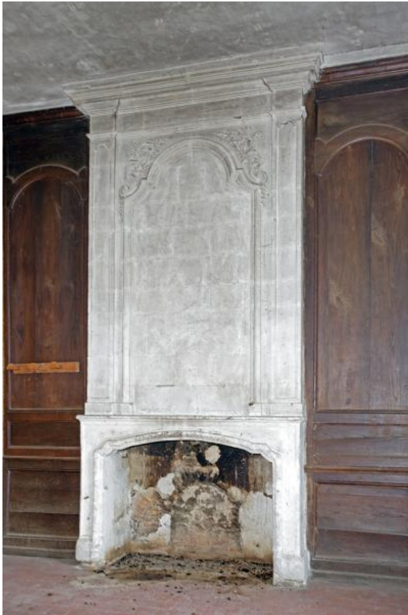
L'aile de communs sud, cheminée.
