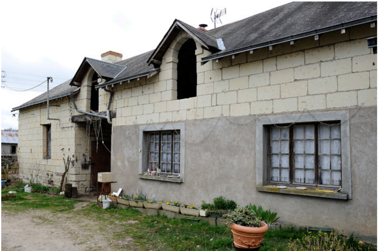
Communs et logement, depuis la cour
