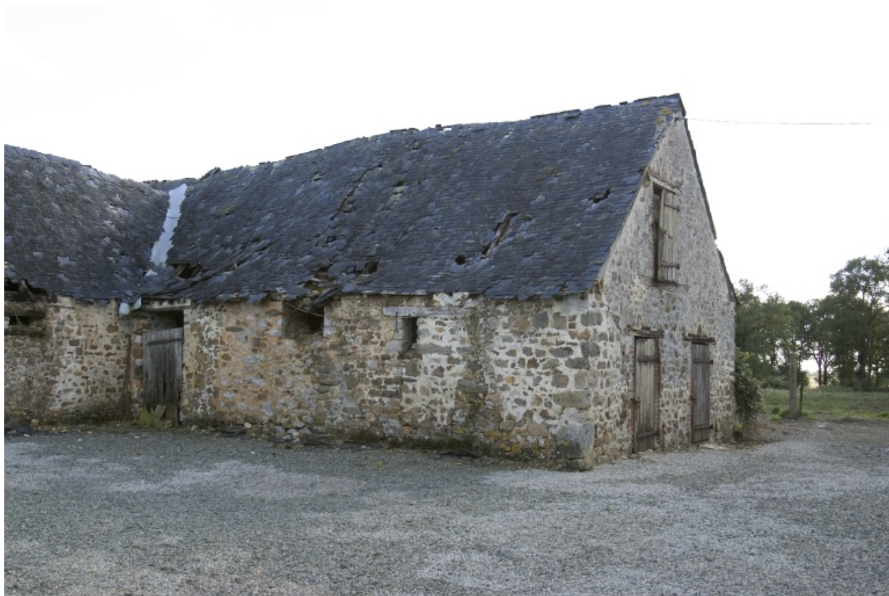
L'aile sud de l'étable vue depuis la cour au nord.
