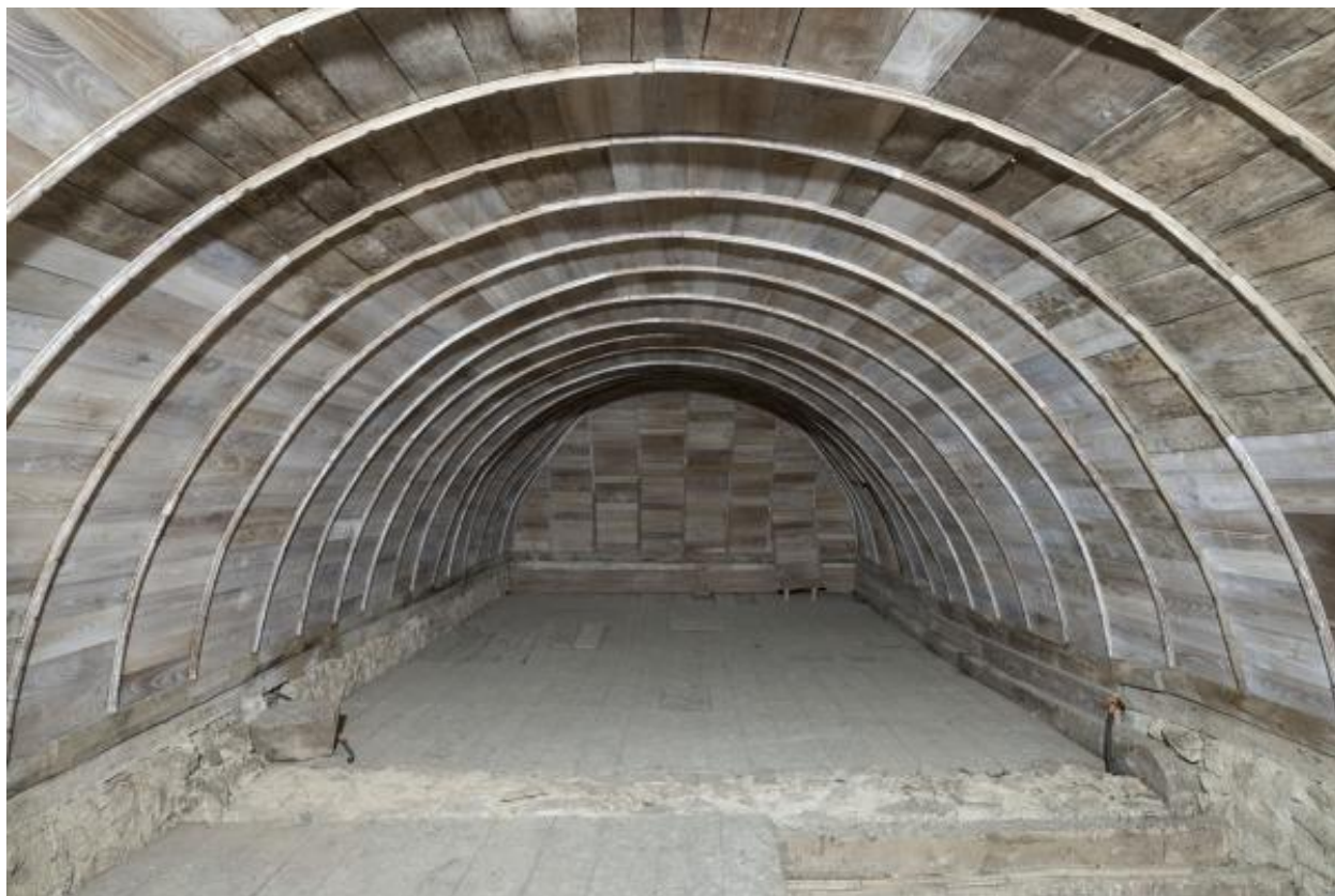
Lambris de la charpente du châtelet.
