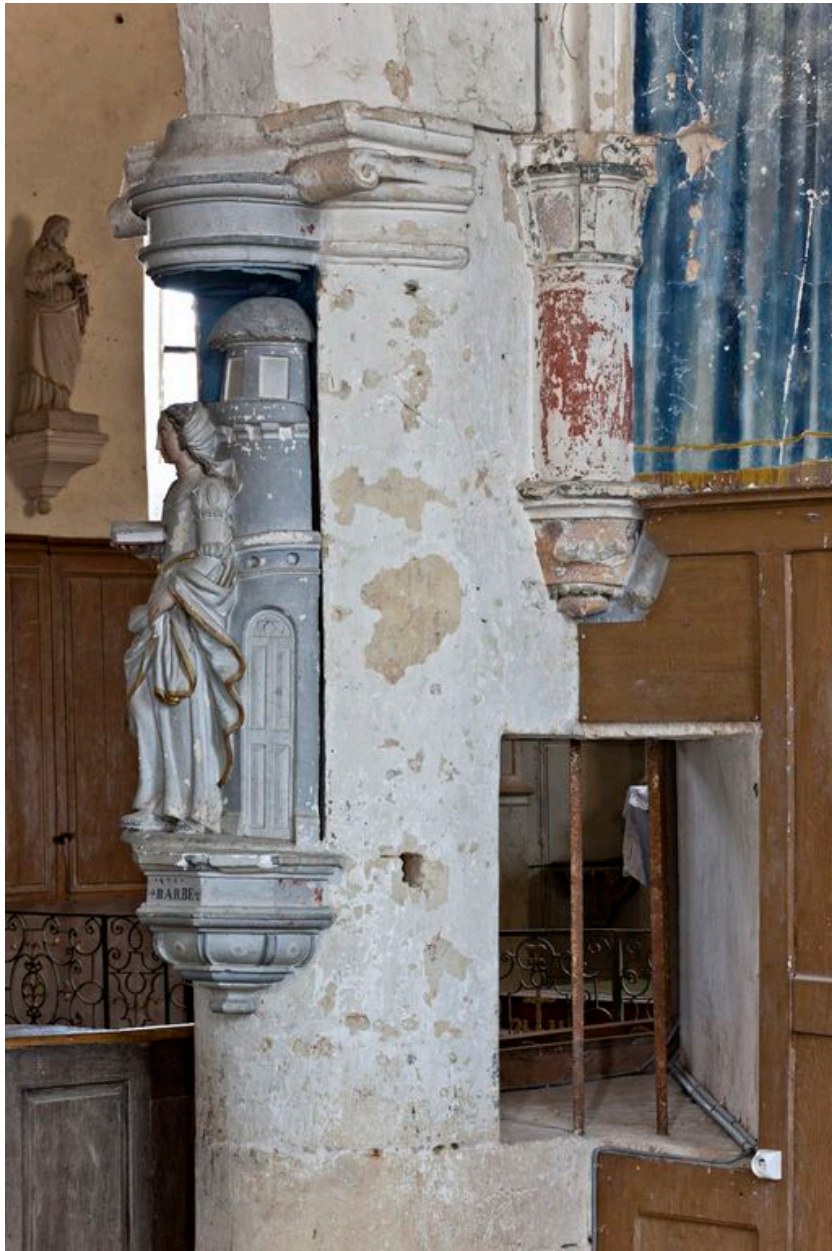
Colonne engagée et colonette sur culot antérieurs gauches de la travée II.
