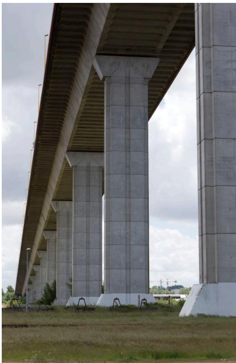
Piles soutenant la partie viaduc.
