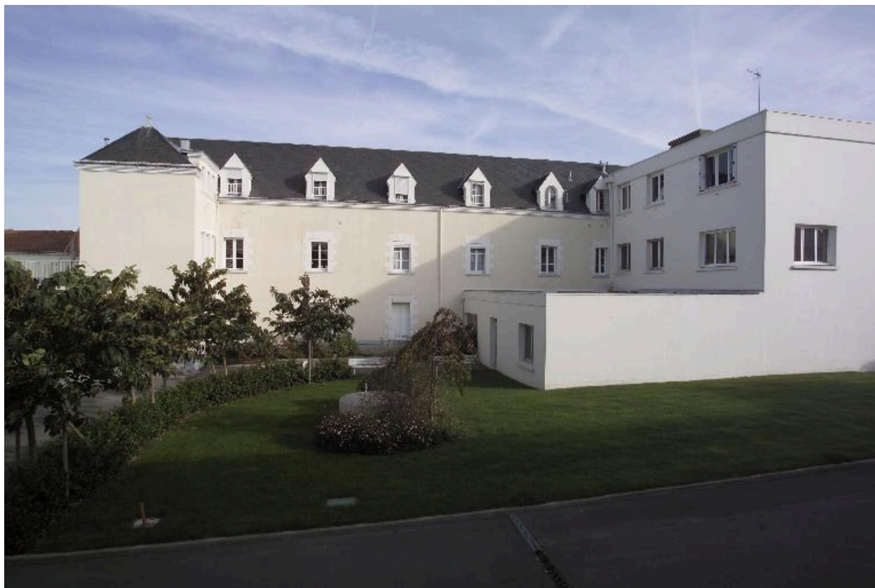
La façade sud, partie ouest.
