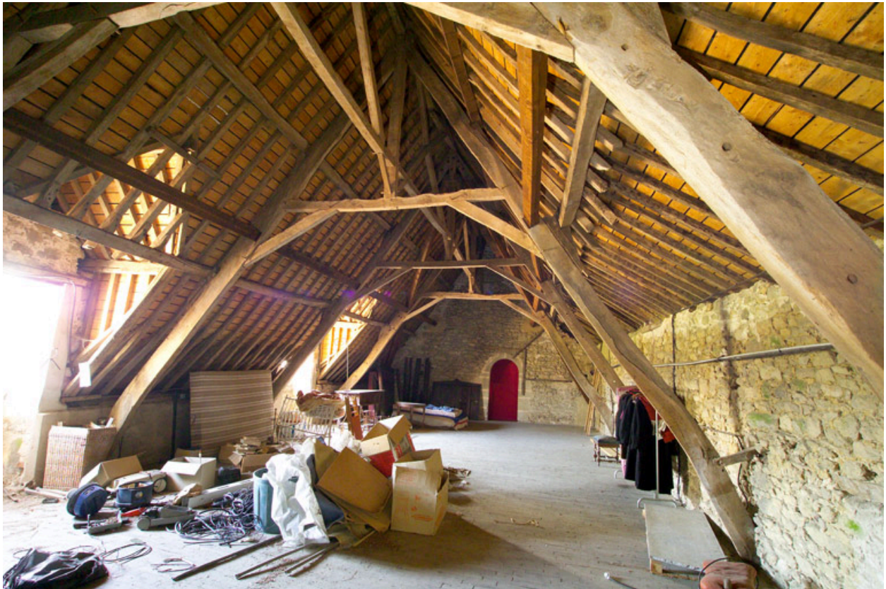
Charpente des anciennes écuries.
