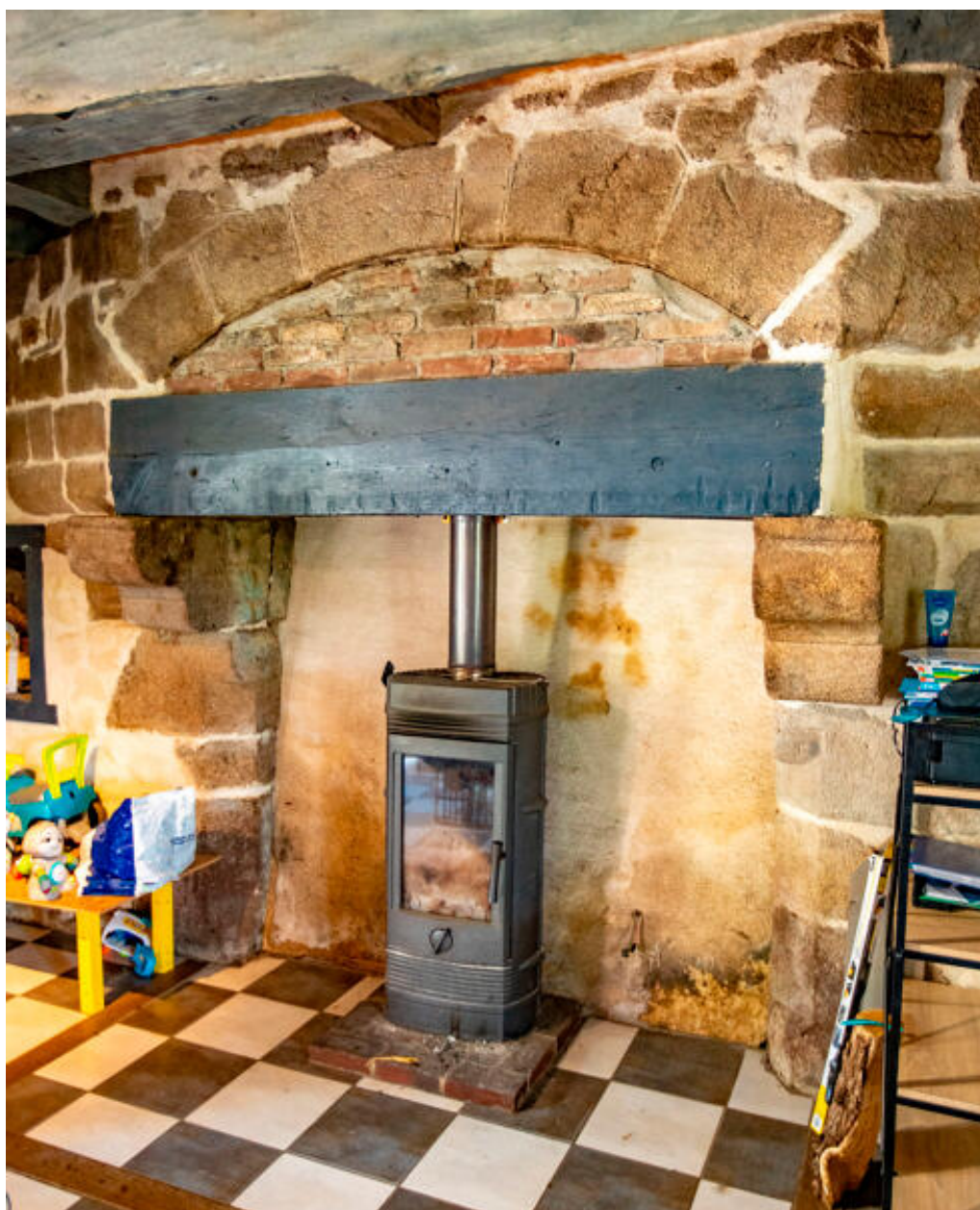
Cheminée de la grande salle (bâtiment 1).
