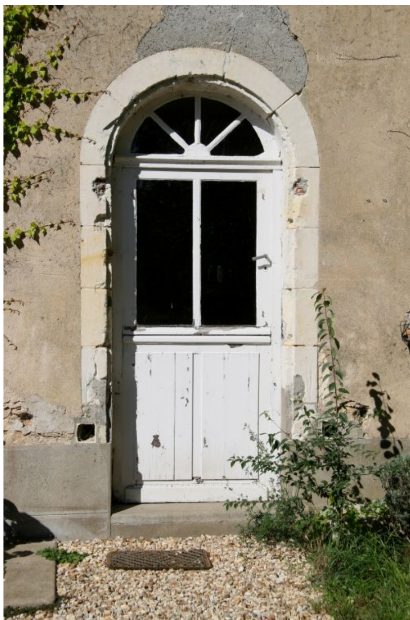
La maison, façade antérieure : porte d'entrée et sa menuiserie d'origine.
