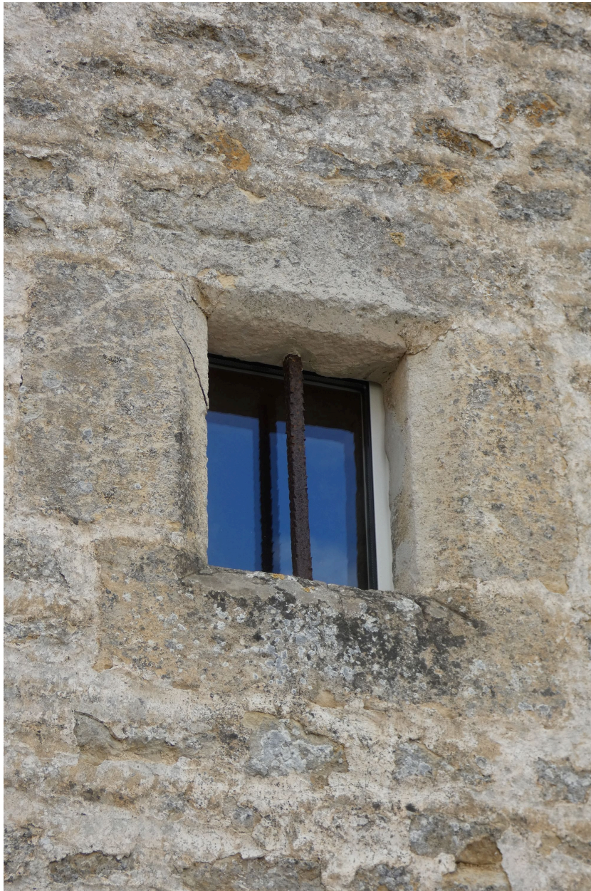
Baie à encadrement chanfreiné sur la façade nord du logement secondaire.
