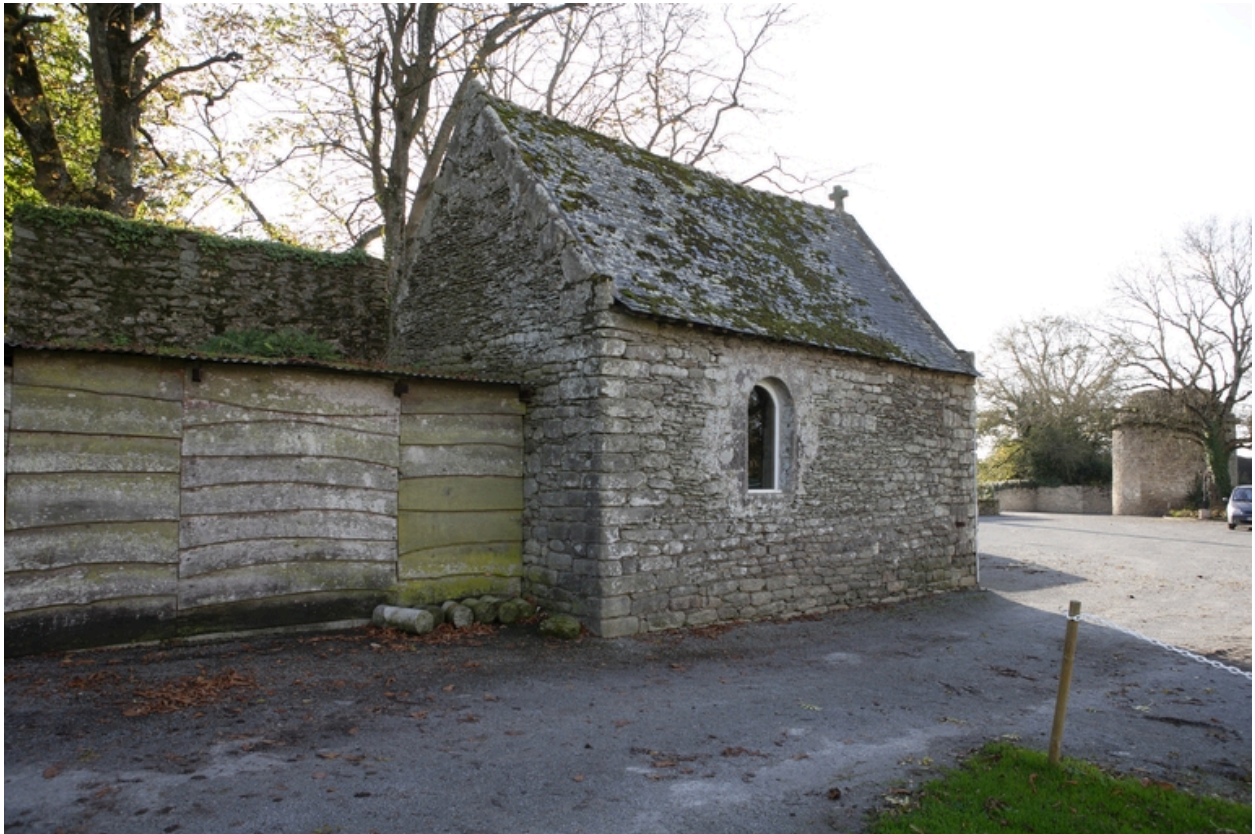
Chapelle. Vue depuis le nord-est.
