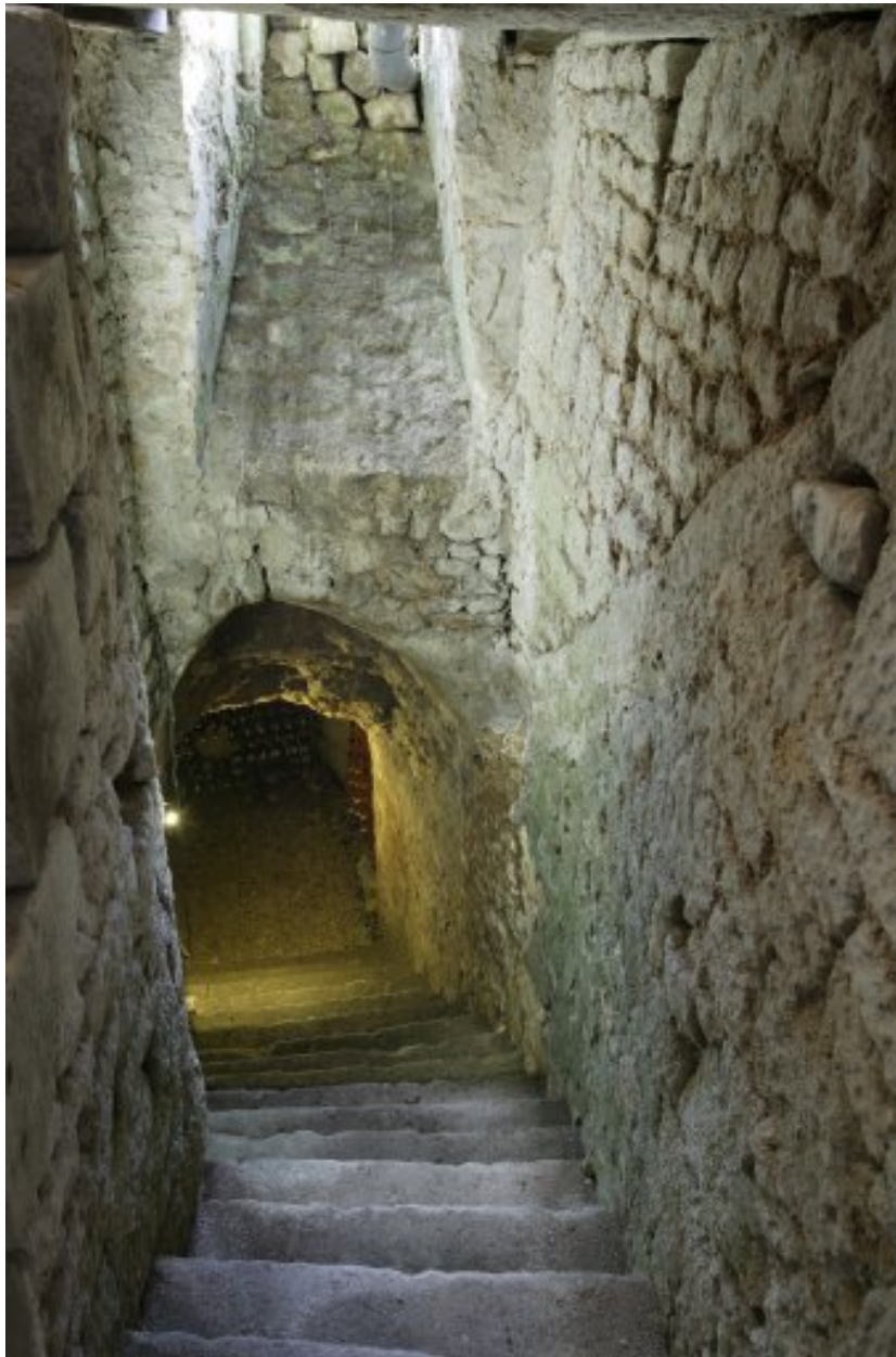
Escalier de descente au sous-sol : vue prise du haut.
