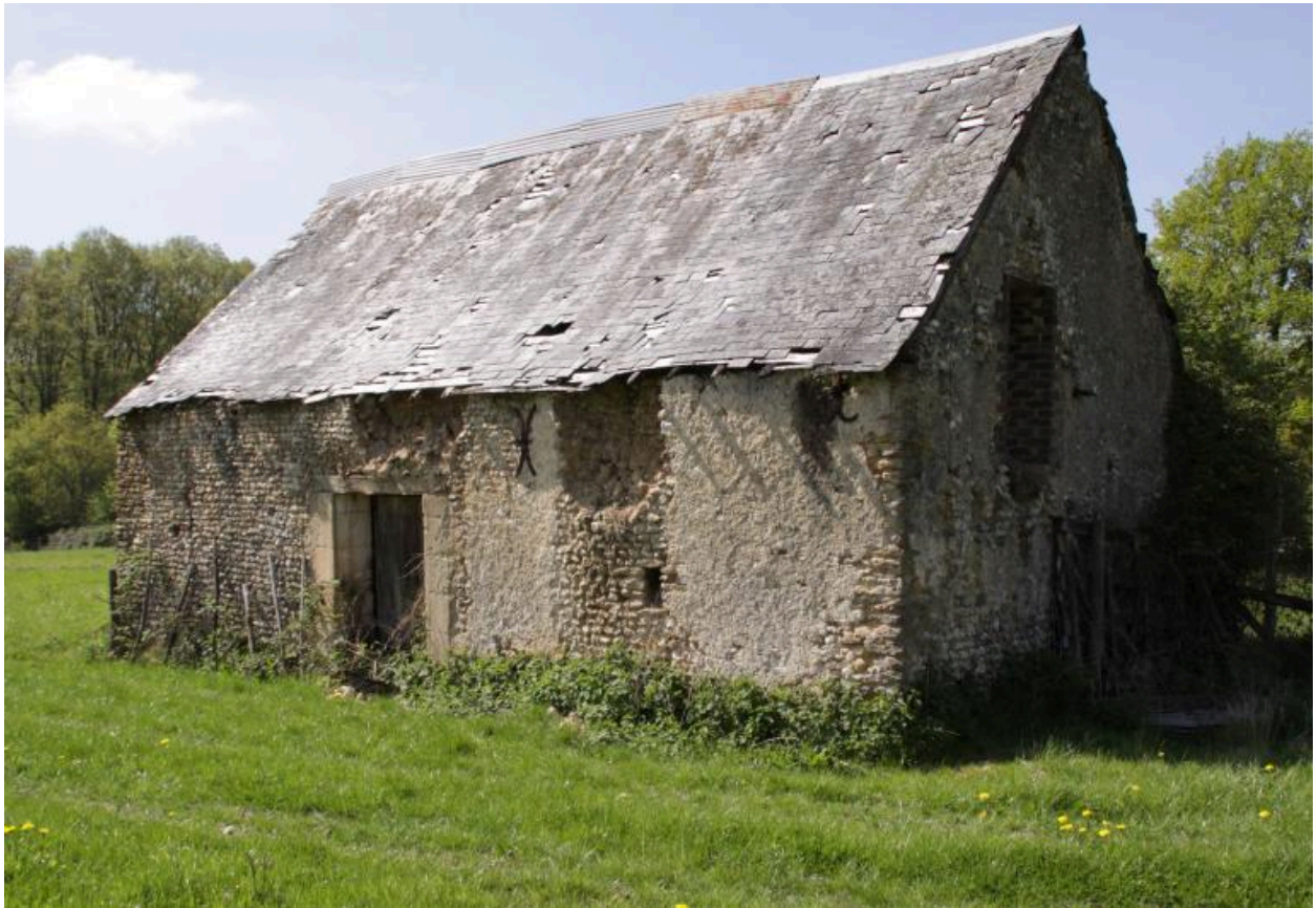
Hucheloup : grange (maison détruite).
