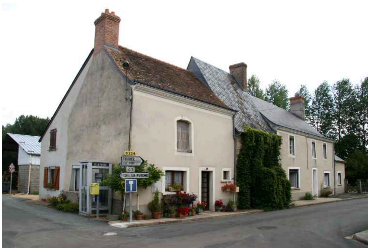
Les maisons 3, 4 et 5 à étage : vue d'ensemble.
