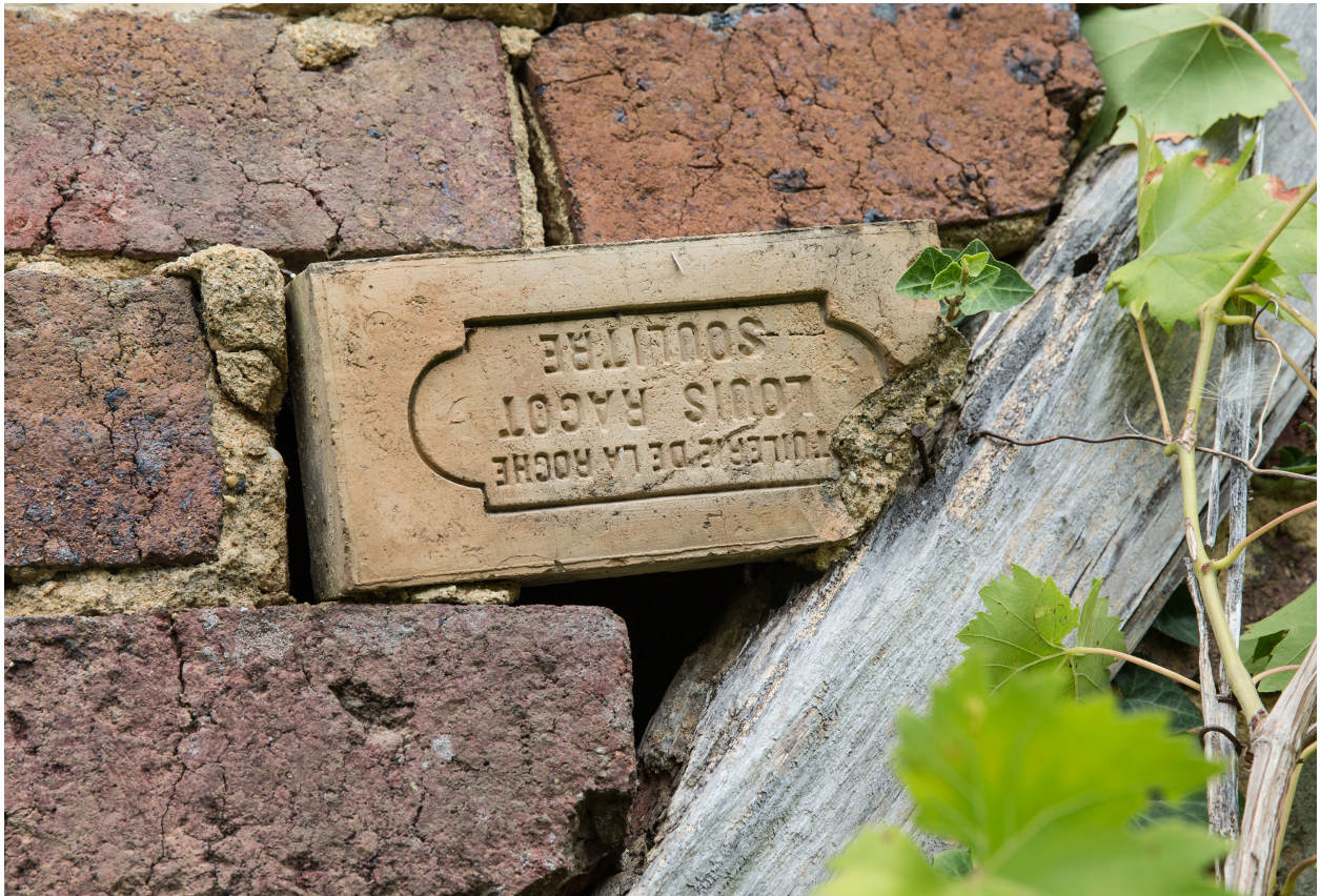
Un détail du mur d'un ancien atelier, une brique de la tuilerie de la Roche à Soultré.
