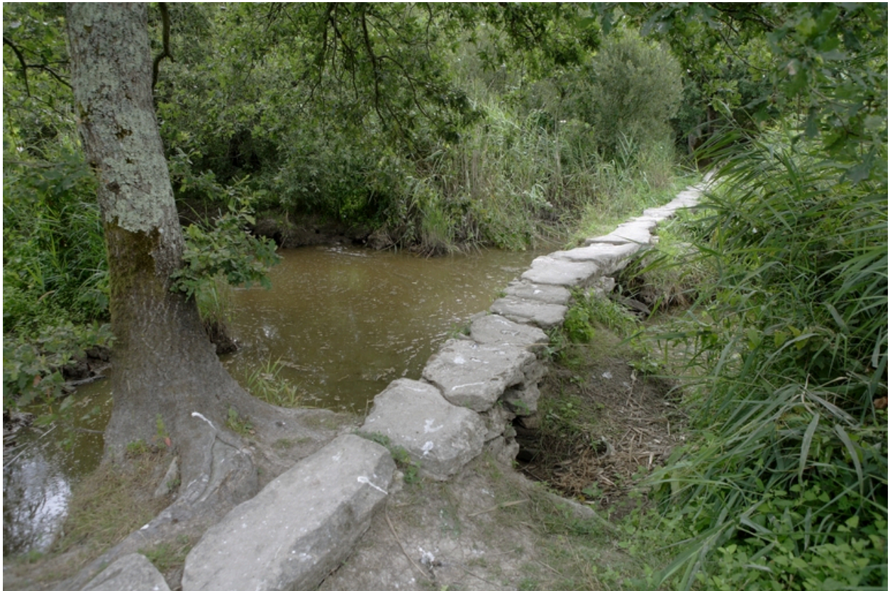
Le pont de Gras, vue depuis l'ouest.
